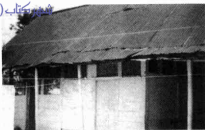
خانه قدیمی سرهنگ در آراکاتاکا قبل از بازسازی.
